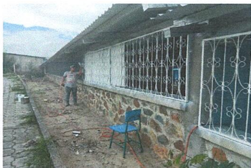
Foto 3: Preparación de la superficie y aplicación de pintura a dos manos, en paredes interiores y exteriores del establecimiento.
