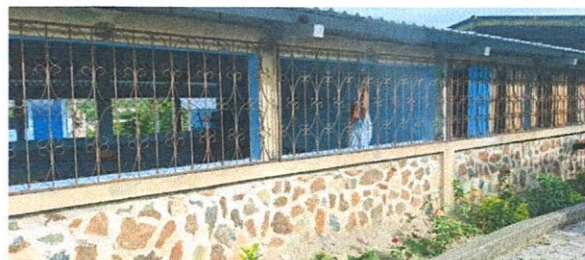
Foto 2: Reparación o sustitución de barandales metálicos, incluyendo fijaciones, pintura y soldaduras.
