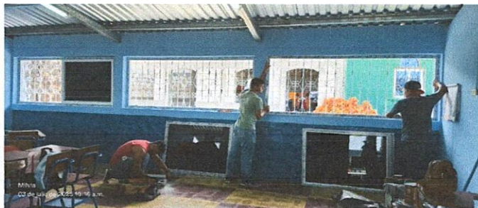
Foto 1: Sustitución de ventanas; sistema de apertura: Corredizas, Perfiles color blanco estandar, Material del marco: PVC Material de la ventana: Vidrio, sellado perimetral.
